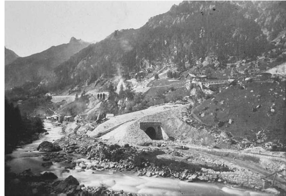
Bau des Higgeribachtunnels, der die Bahn vor Lawinen schützt, unterhalb Wassen
