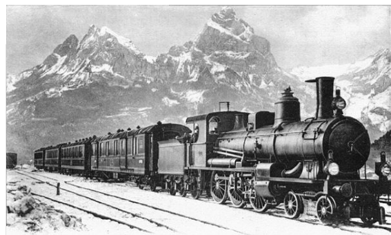
Gotthard-Express Luzern–Mailand mit Lokomotive A 3/5 Nr. 202 und neuen Vierachsern 1. und 2. Klasse. Während die Loko-motiven vom Gebirgscharakter der Gotthardstrecke geprägt wa-ren, zeichneten sich die Reisezugwagen der Gotthardbahn von Anfang an durch einen besonders hohen Komfort aus.
