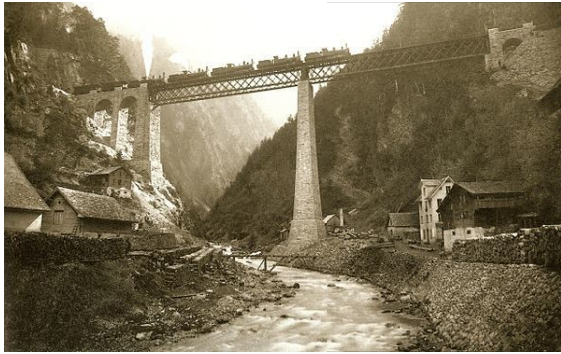
Belastungsprobe der Chürstelenbachbrücke bei Amsteg um 1880
